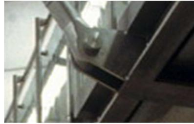
*Figura 2. Detalle de los extremos de los tirantes de soporte.*
